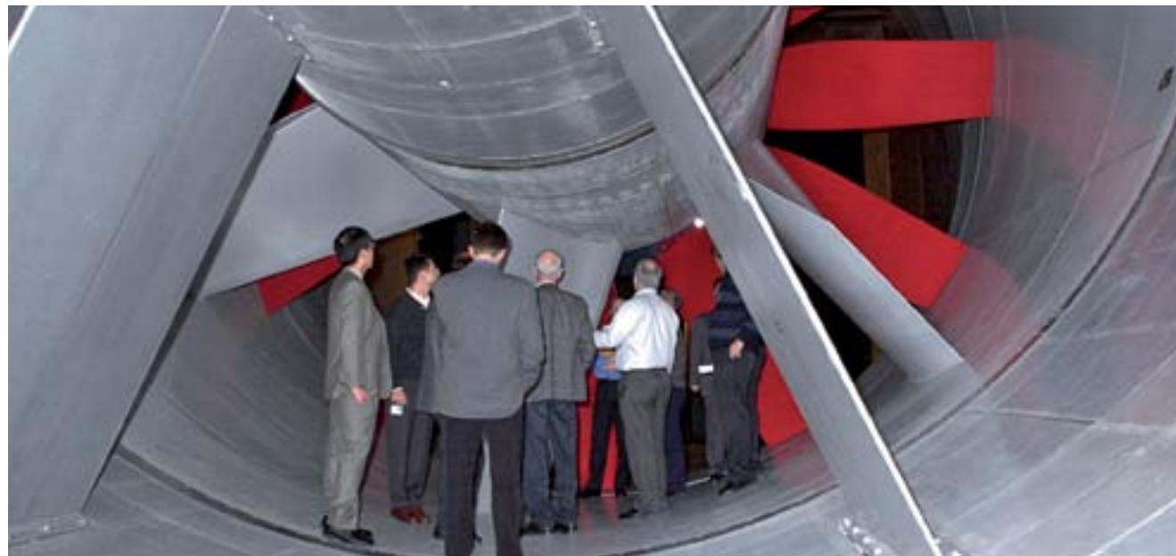
Ventilator mit Schalldämpfer; DaimlerChrysler, Auburn Hills, USA Fan Silencer; DaimlerChrysler Auburn Hills, USA
