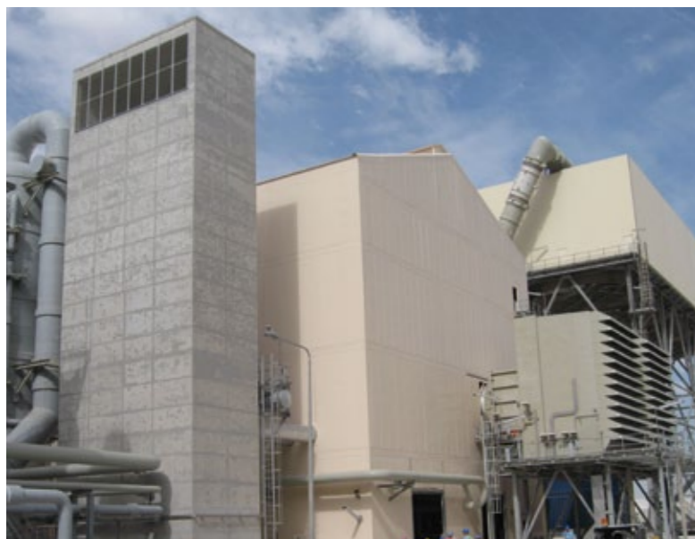
Система звукоизоляции компрессоров Linde AG; проект Перл Катар, Кувейт
