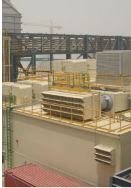
Звукоизолирующее здание газовой турбины GT-13 с системой вентиляции Alstom AG; проект Аз-Зур, Кувейт.
