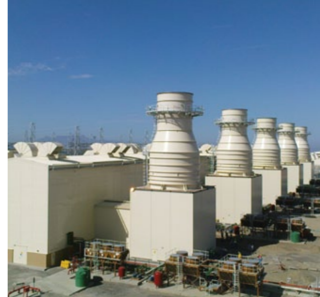
Звукоизоляционные укрытия для газовых турбин Siemens AG; проект Рошкон, ЮАР
