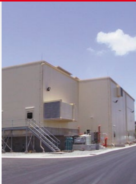
Звукоизолирующее укрытие паровой турбины Siemens AG; проект Таунсвилль, Австралия.
