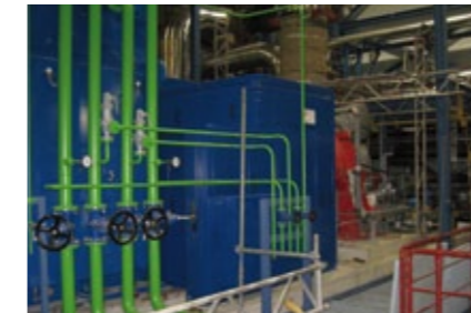
Защитный блок редуктора TGM Kanis; проект Платтинг, Германия
