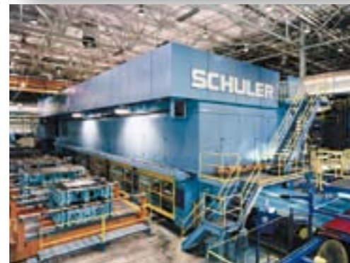
Bild oben Schallschutzverkleidung für eine Tiefdruckmaschine. Schalldämmung: 30 dB
