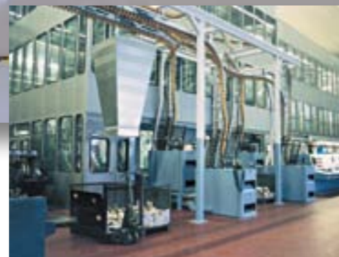
Hoch absorbierende BKA Module garantieren Halbfreifeldbedingungen im Fahrzeugprüfstand des Fraunhofer-Instituts für Bauphysik in Stuttgart.
